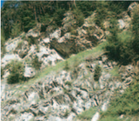
Hydrosaat mit Gräser-Kräutern bzw. Gehölzen auf großflächigen Felsböschungen (Südtirol)
